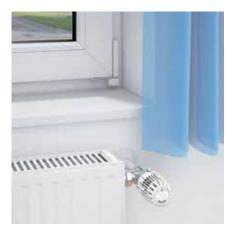
**Correcto:** Se permite la circulación de aire alrededor del cabezal.
