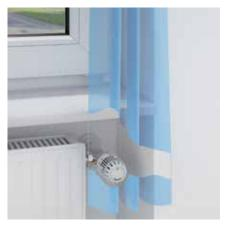
**Incorrecto:** La cabeza termostática con sensor integrado no debe cubrirse con cortinas o muebles.
