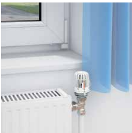
Feil Termostathode med innebygd sensor kan ikke monteres vertikalt.
