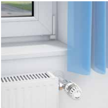
Korrekt Luft sirkulerer fritt rundt termostathodet.
