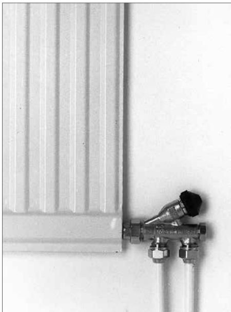
1-strengsventil, sidemonteret
