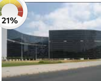
Clădire administrativă, Brazilia Sistem de răcire a birourilor Economie de energie 21%
