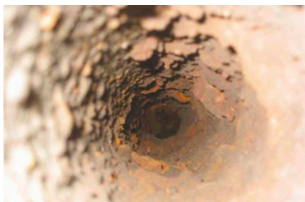
Widok wewnętrzny rury 4» (DN 100) spowodowany korozją
