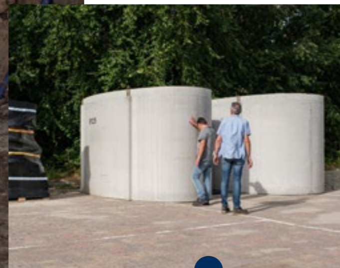
De twee regenwaterputten met een capaciteit van 20.000 liter regenwater.
