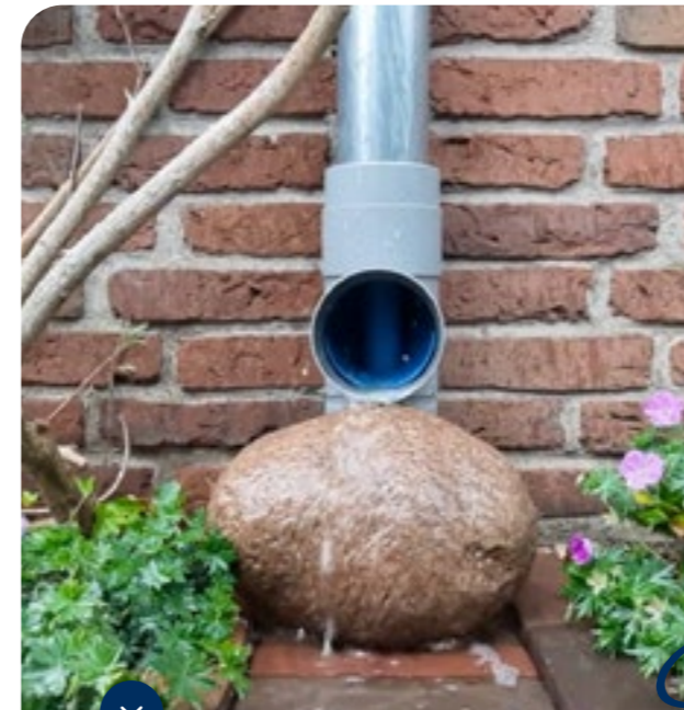
Eenvoudig afkoppelen met behulp van de regenwater afkoppelset.
