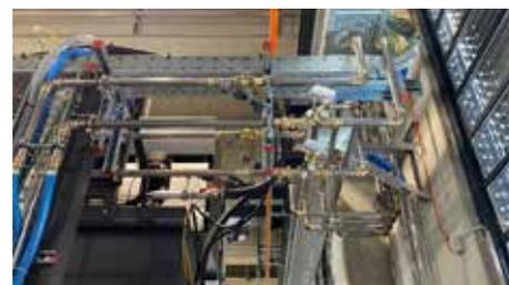
La valvola è controllata tramite comunicazione bus, nello specifico BACnet MSTP. Inoltre, il consumo energetico di ogni TA-Smart viene monitorato e registrato a livello centralizzato.
