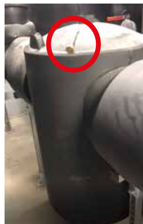
Differenza tra magneti utilizzati dai concorrenti (in cima al separatore) e Zeparo ZIO/G-Force
