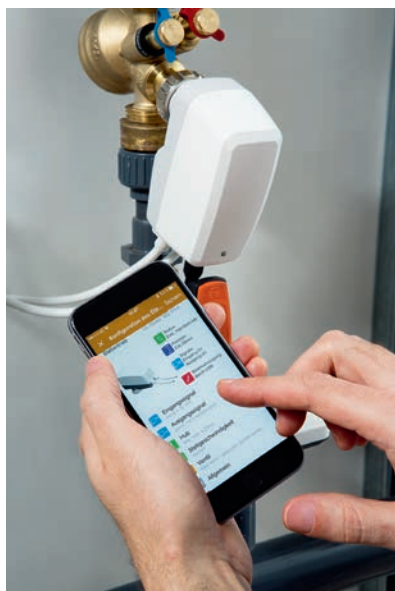
Figure 8 : Réglage digital du débit via le moteur.
